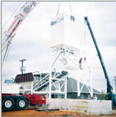
Silo de cemento articulado y alimentado por gravedad
